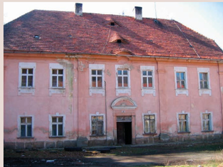
5. Elewacja wschodnia pałacu w Ulanowicach, stan z marca 2007 roku: widoczny brak kartusza herbowego nad drzwiami wejściowymi. Za udostępnienie tej archiwalnej fotografii dziękuję Nadleśniczemu Dariuszowi Gajdzie z Nadleśnictwa Kamienna Góra.
